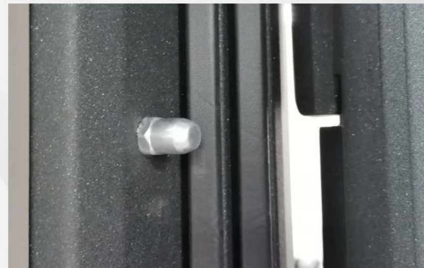
Резьбовой противосъёмный штырь
